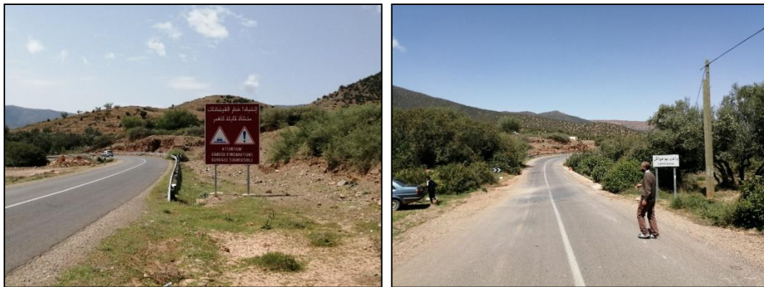
Photo 1 : Tronçon étudié de la Route Nationale n°19 sur Oued Debdou (21/11/2020)
