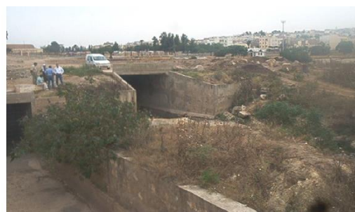
Photo2: Amont de la zone d'étude-exécutoire du canal aménagé de l'oued
