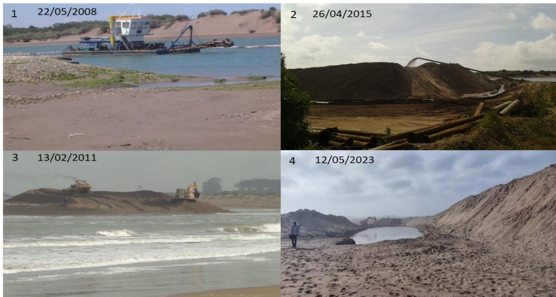
Photos 5 : changement des plates formes de dragage de DRAPOR 1et 2 sur le chenal 3 et 4 dans l'embouchure.
