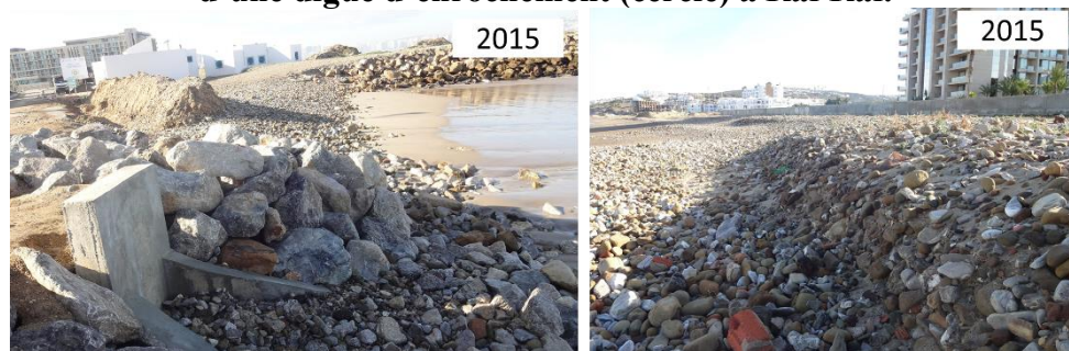
Fig. 5. Nouvelle granulométrie de la plage dans la partie orientale de la plage de Tanger protégée par des épis et brise-lames.
