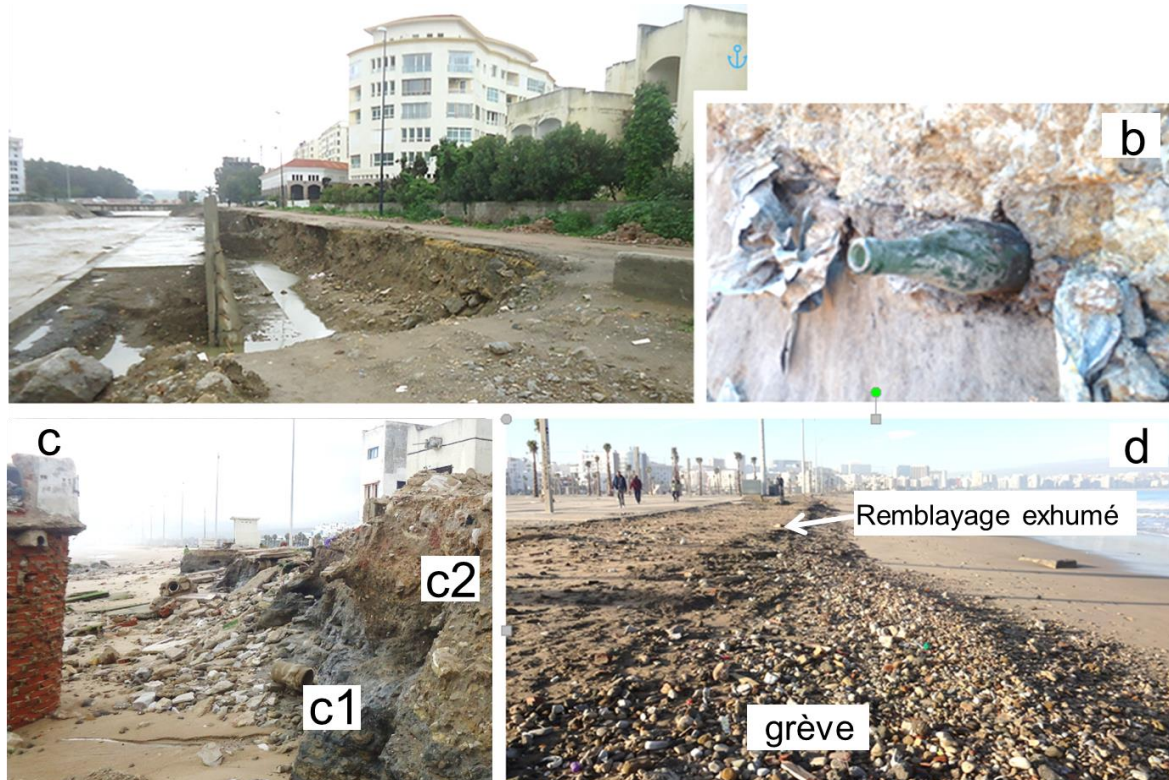
Fig. 2. Le matériel utilisé dans le remblayage de la côte de Tanger : a- dans une coupe mise au jour à l'intérieur de l'espace bâti dans les berges de Oued Mghogha suite à une crue (avril 2013) ; b- détail de la photo a ; c- dans une falaise évoluant aux dépens de constructions (avril 2013) maintenant disparues suite aux récents travaux d'aménagement : c1- matériel d'origine marine, c2- matériel de déchardes ; d- grève formée par un matériel issu du remblayage (à marée basse ; déc. 2015) (photos de l'auteur).
