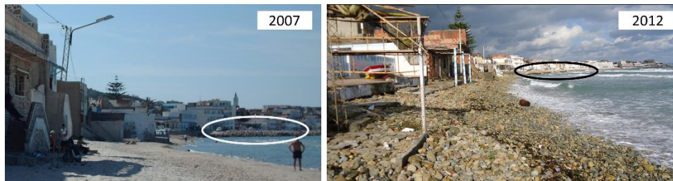
fig. 4. Transformation d'une plage sableuse en une grève après l'implantation d'une digue d'enrochement (cercle) à Raf Raf.
