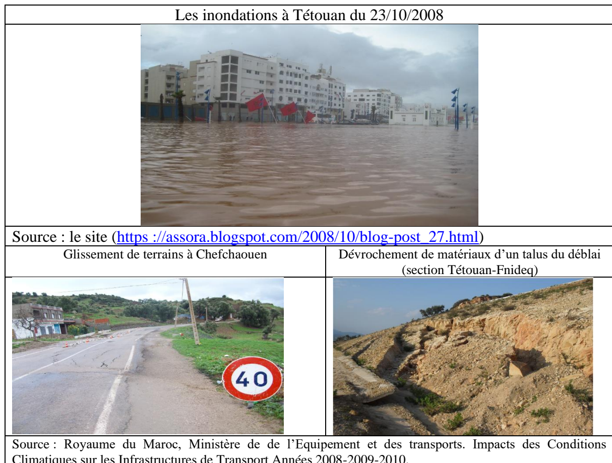
Figure. 2. Effets des crues sur l'infrastructure dans le Rif occidental
