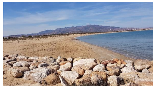
Photo.5. Accrétion au niveau de la digue
