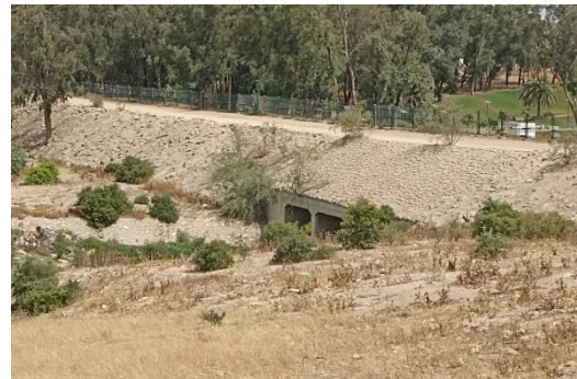
Photo1: Aval de la zone d'étude Digue Lac Mzamza
