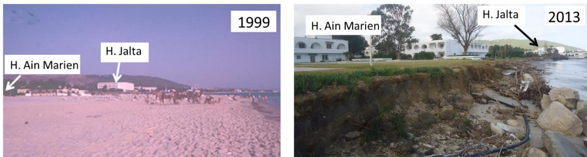
Fig. 3. L'évolution de la plage dans une partie de la côte de Bizerte. Après l'érosion de la plage, les vagues révèlent la vraie nature du matériel sur lequel ont été menés les aménagements de front de mer : un remblayage dont les matériaux vont être incorporés au sable de l'estran (photos de l'auteur).
