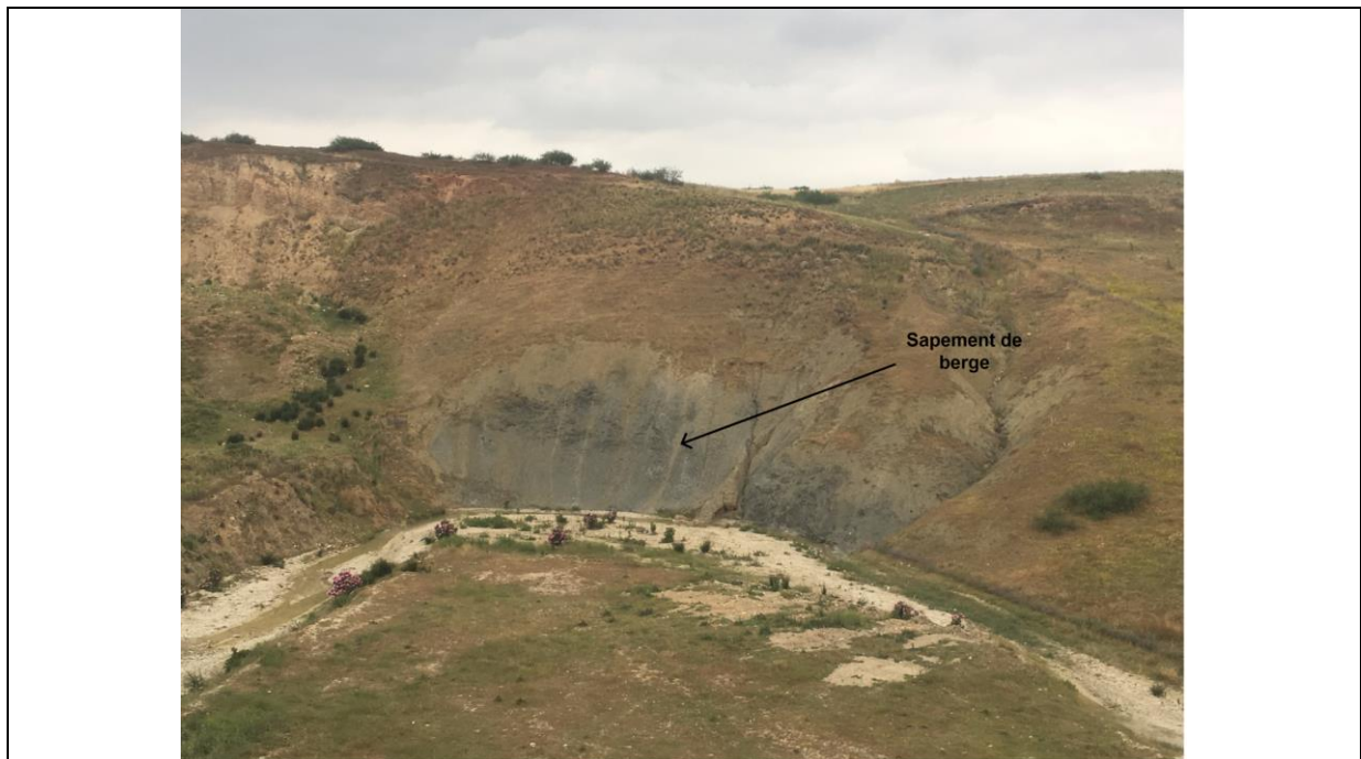
Photo 3 – Aspect de dégradation des versants marneux par sapement des berges de l'oued Aghrouz
