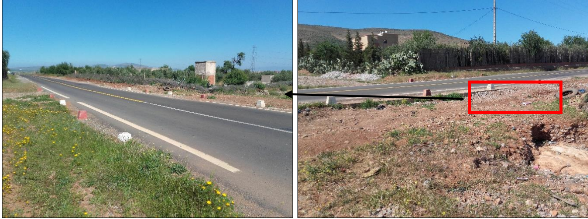
الصورة رقم 1: مشاهد من غمر المياه (طريق عين الصفا، 11-04-2017)
