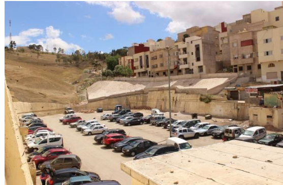
Confortation généralisée du pied du versant au niveau du parking public
