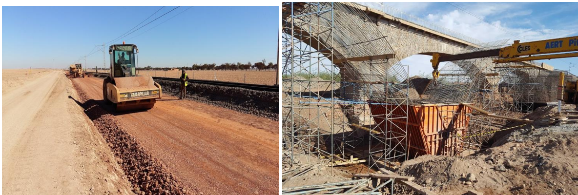
Figure 10 : Photos illustrant les travaux en cours
